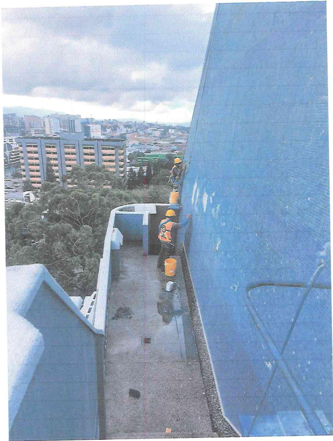
Liberación de agregados en la fachada oriente del sector A2.
